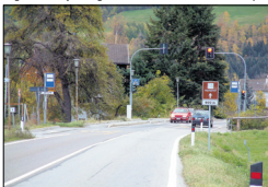
Die „Autobahn“-Ampel (rechts) auf der Einmündung der Agumser Gasse in die Landesstraße Prad-Glams (links) wird durch einen Kreisverkehr ersetzt.
